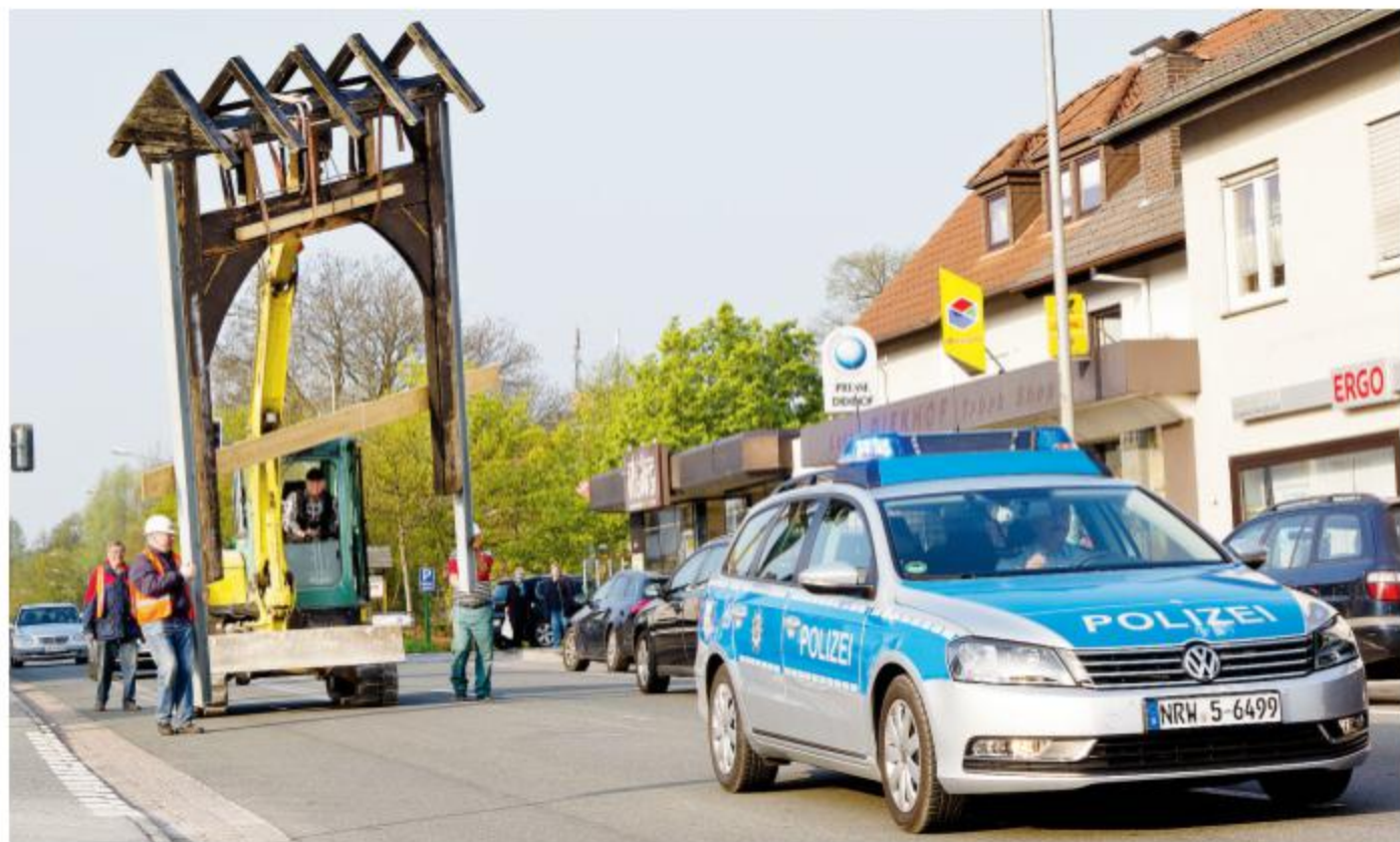
Unterwegs zum neuen Standort: Am Bagger von Rainer Meier überquert der alte Torbogen die Augustdorfer Straße.
